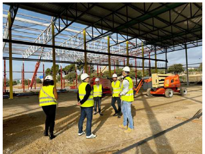
Visita a la obra de las nuevas instalaciones de igus SLU con las autoridades de Vilanova i la Geltrú y los medios de comunicación locales. (Fuente: igus SLU)
